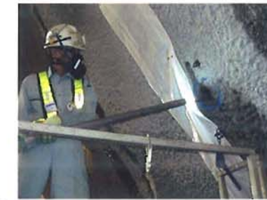
BIPシステムにおける測定(トンネル前方調査)
